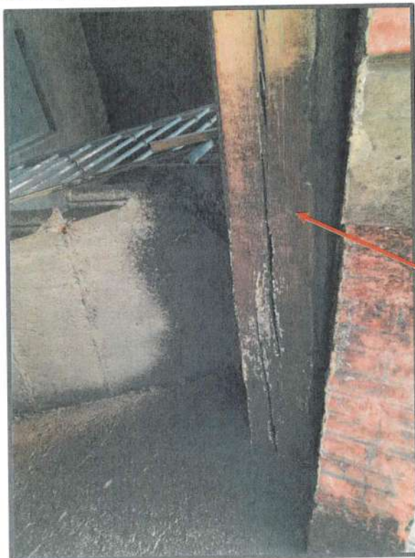
Figure 15 : Vue sur la poutre bois située derrière la voûte en brique (P7)
