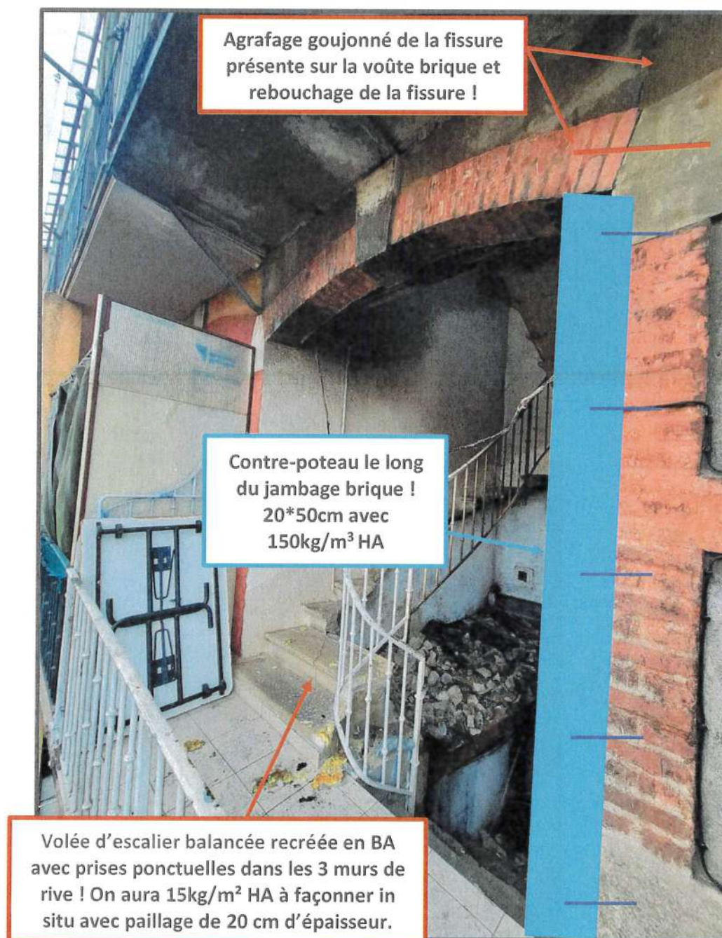
Figure 11 : Reprise de la voûte en brique
