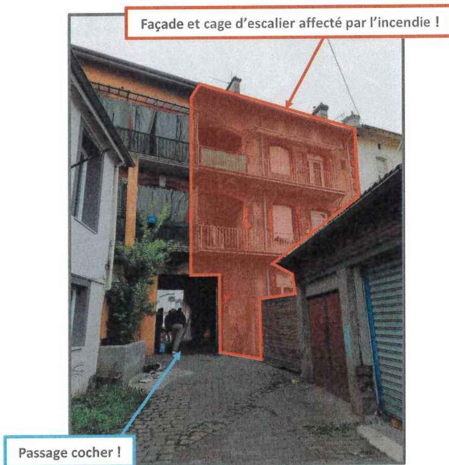
Figure 4 : Vue sur la façade touchée par l'incendie (cour arrière)
