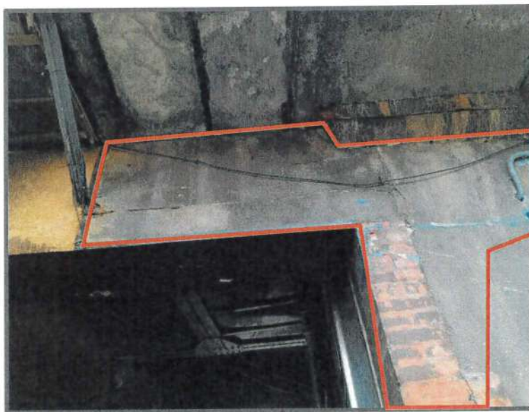
Figure 10 : Zoom sur la zone singulière au niveau de la façade arrière (côté cour)
