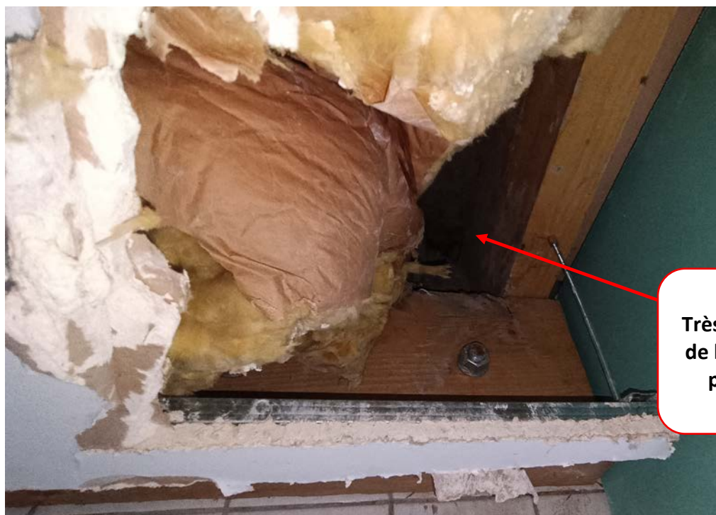
Figure 44 : Etat des lieux – photo de la composition du plafond de la salle de bains.
