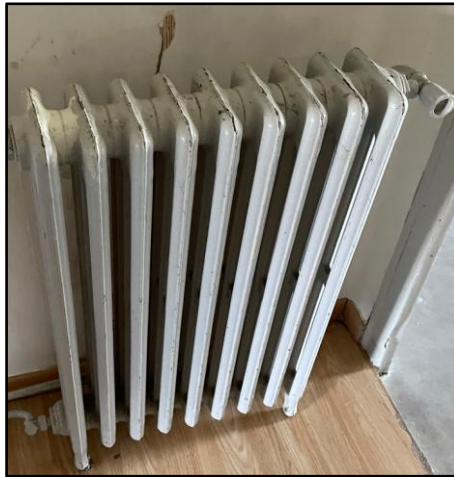
Radiateur fonte équipé d'un robinet simple
