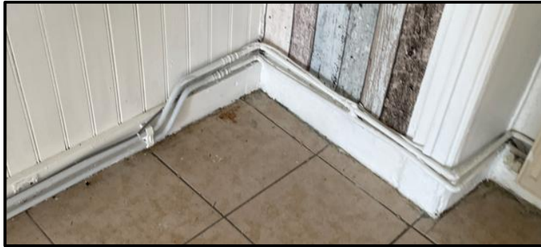
Distribution tube cuivre de chauffage type bitube en plinthe
