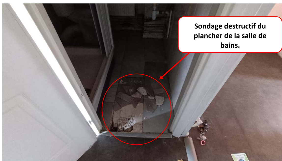
Figure 53 : Etat des lieux – Photo de l'appartement 4
