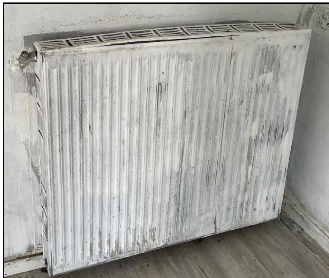
Radiateur acier vétuste dépourvu de robinet
