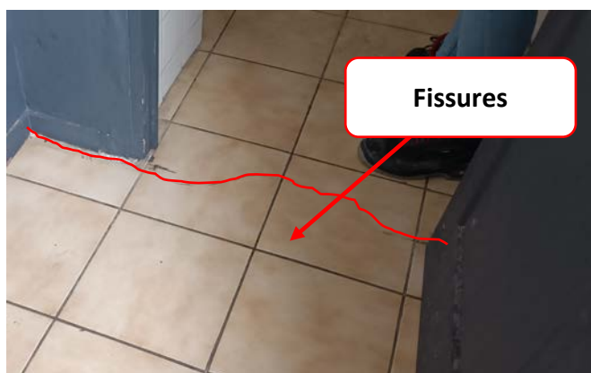
Figure 34 : Etat des lieux – Photo de la fissure parcourant le carrelage en proximité directe de la salle de bains
