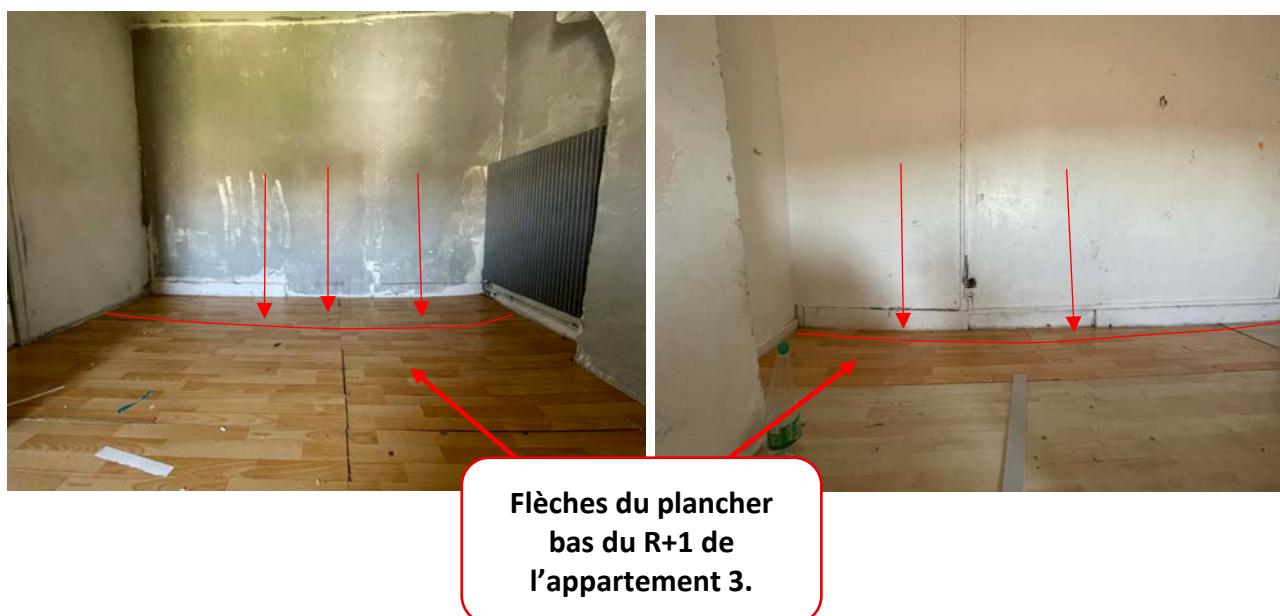
Figures 59 et 60 : Etat des lieux – Photos du plancher bas du R+1 de l'appartement 3
