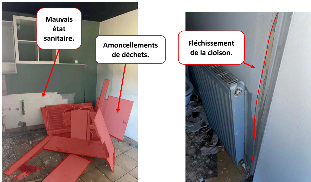
Figures 17 et 18 : Etat des lieux - Photos de l'appartement 2
