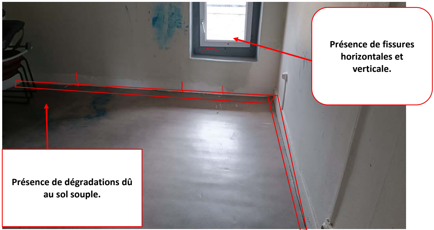
Figure 49 : Etat des lieux photo d'une pièce de l'étage de l'appartement numéro 2
