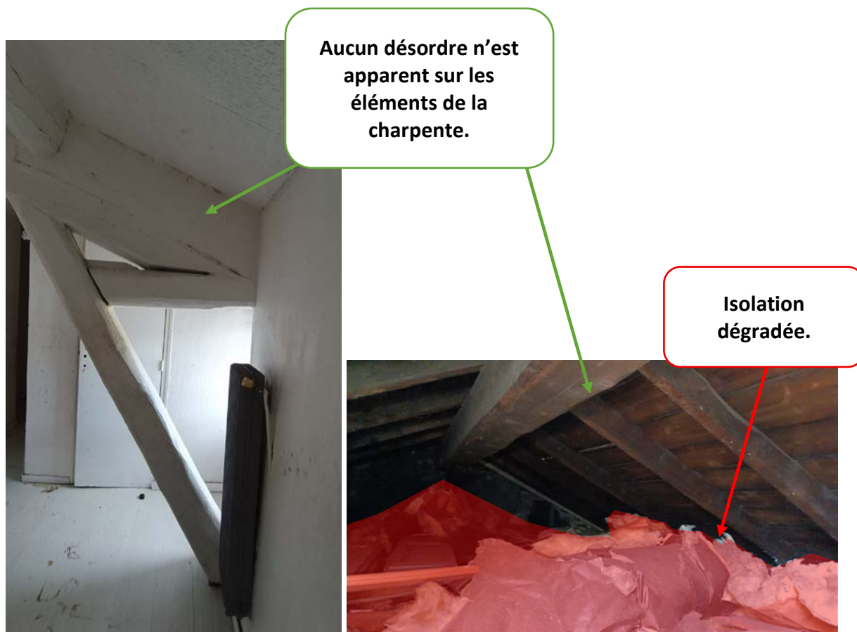
Figures 62 et 63 : Etat des lieux – photo d'une section de la charpente située au R+1 de l'appartement numéro 4 et photo prise dans les combles
